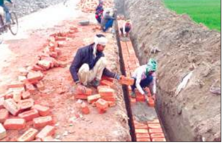
नाले का हो रहा निर्माण
