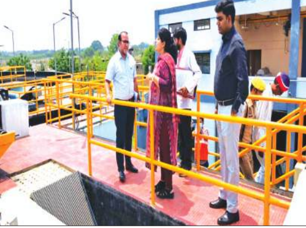
रायबरेली समृद्धि न्यूज़। जिलाधिकारी सरनीत कौर ब्रोका ने नगर क्षेत्र में पीएसी के निकट स्थापित एसटीपी (सीवेज ट्रीटमेंट प्लांट) एवं एफएसटीपी (फीकल स्लज ट्रीटमेंट प्लांट) का स्थलीय निरीक्षण किया। निरीक्षण के दौरान उन्होंने प्लांट की कार्यप्रणाली, साफ-सफाई व्यवस्था तथा सीवेज एवं फीकल स्लज के निस्तारण संबंधी व्यवस्थाओं का जायजा लिया। जिलाधिकारी ने
