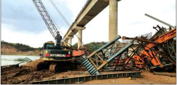
तूफान के अलर्ट के बाद भी चल रहा था निर्माण
