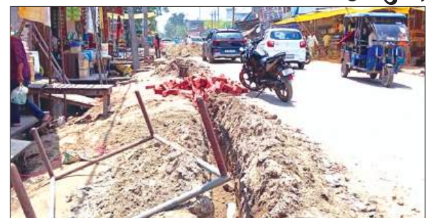
पाइपलाइन डालने के खोदे गये गड्ढे
